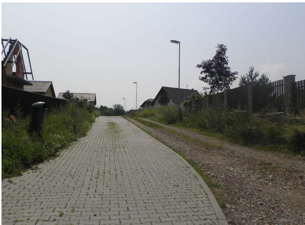
obr. 9 – nedokončené povrchy komunikací
