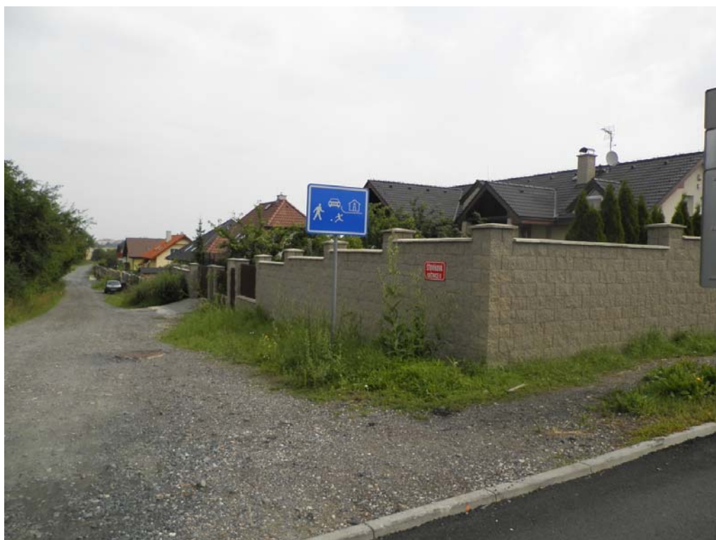
obr. 1 – bariérové oplocení, nebezpečné komunikace a chodníky
