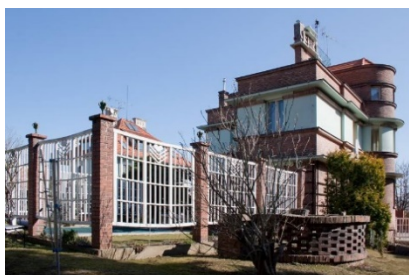
Vondrákova vila, Praha-Střešovice, Západní 21, zahradní průčelí
