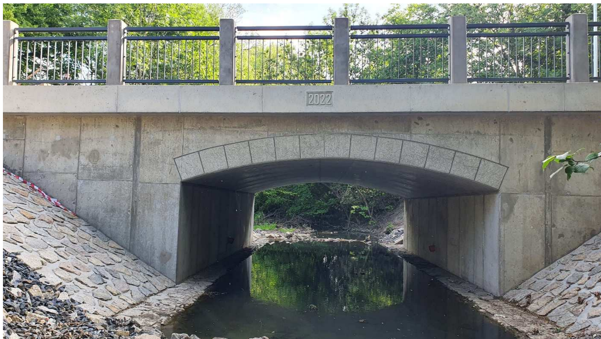
Příloha – foto z mostu v Říčanech:
