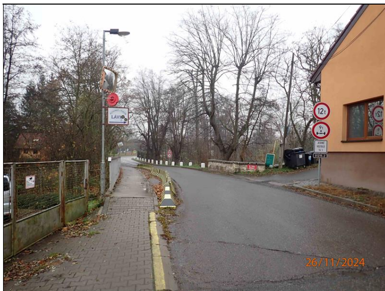
01 po směru staničení.JPG
