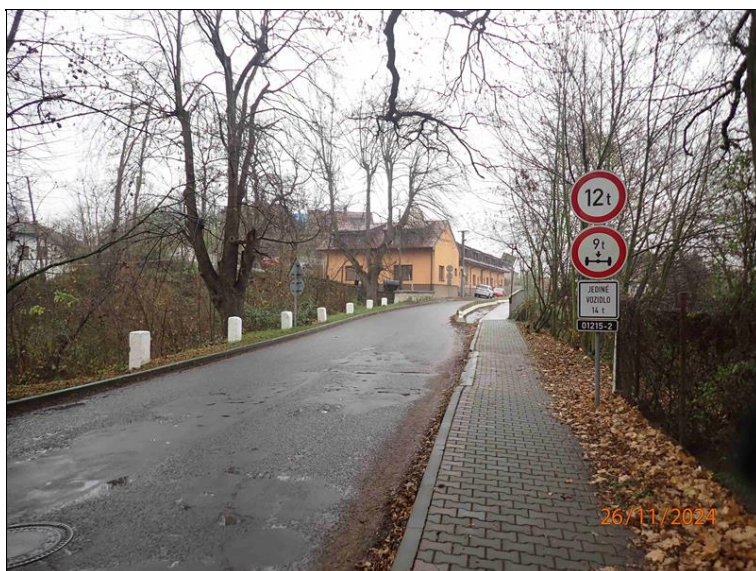
02 proti směru staničení.JPG
