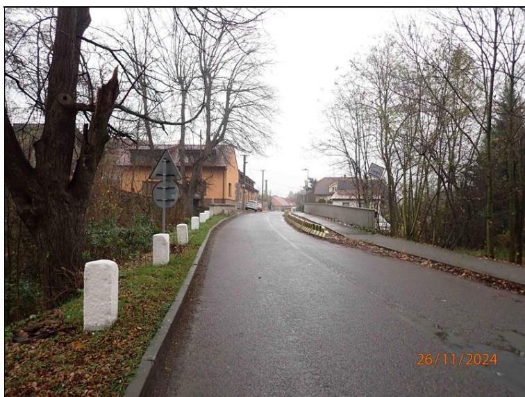
03 proti směru staničení.JPG
