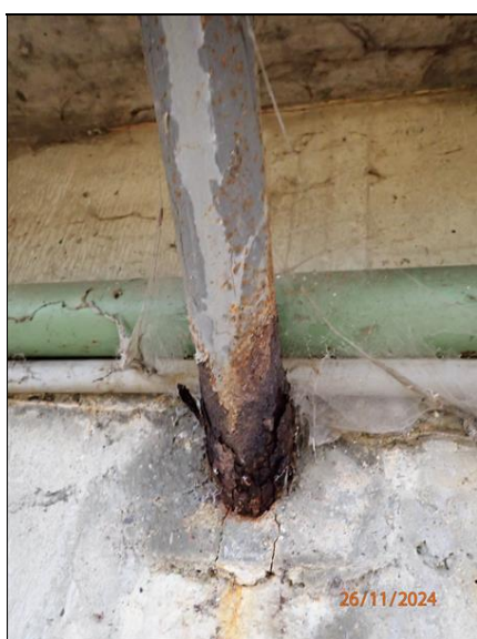
24 OP2 levé křídlo konzola.JPG
