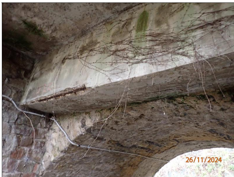
28 NK beton klenba.JPG
